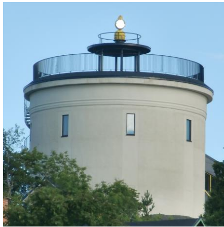
Flygfyrn på gamla vattentornet i Norrtälje. Nya badhuset skymtar i bakgrunden. Foto BoJu 2016.
