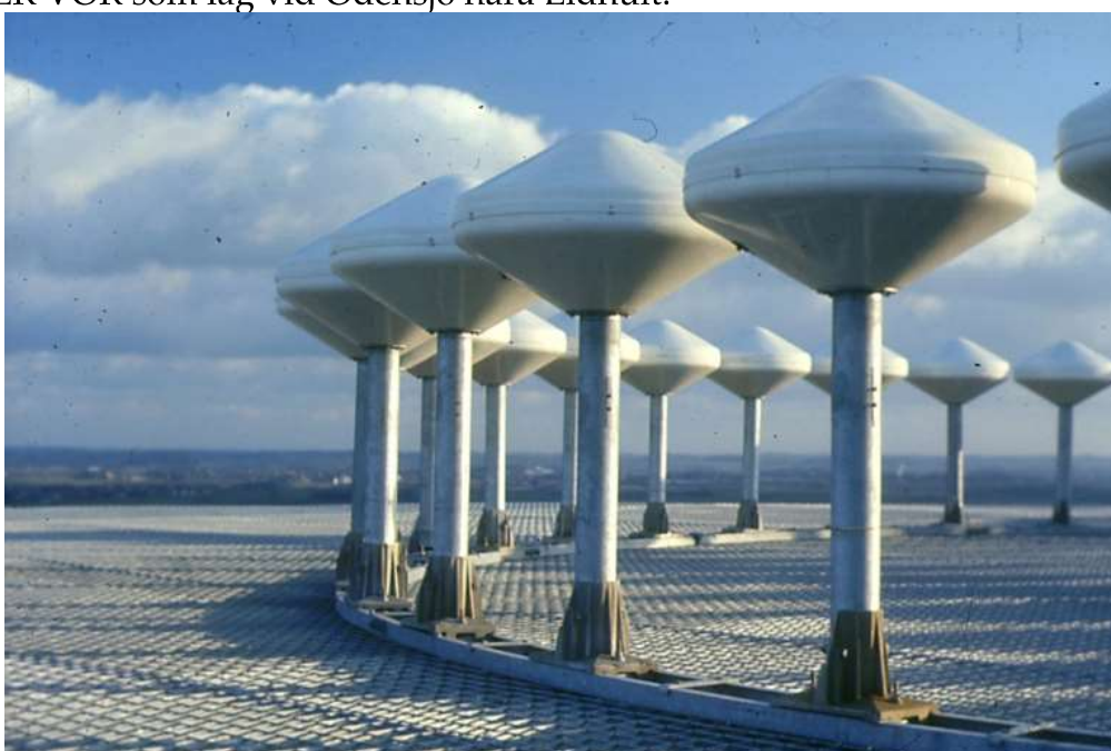
En närbild på några av de 39 antennerna på ASTOR VOR som fanns i Åstorp.
